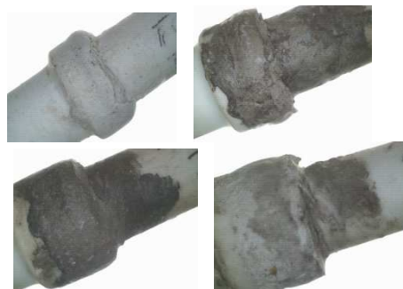
Рис. 5. Состояние узлов с помещенными на них составами после испытаний
