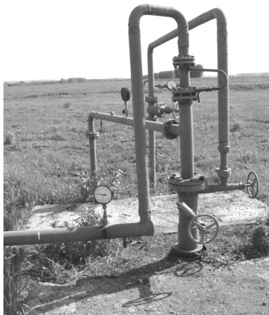
**Рис. 3.** Скважинная установка предварительного сброса воды после 4,5 лет эксплуатации
